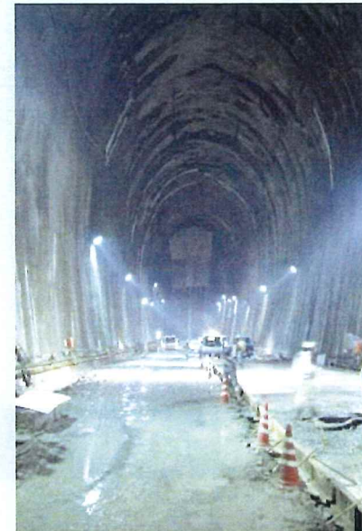
倉敷基地地下貯槽の様子 (建設時)
